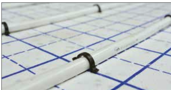
Fixation avec tacksers sur l'insulPano HF35
