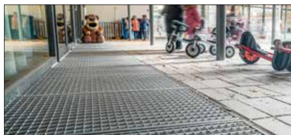
À l'entrée par laquelle les enfants pénètrent dans le bâtiment depuis la cour de récréation, le choix s'est porté sur le CleanBox, un paillason modulaire drainant.
